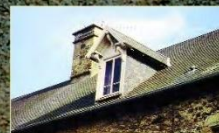
Lucarne en bâtière
