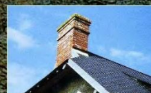
Souche de cheminée en brique
